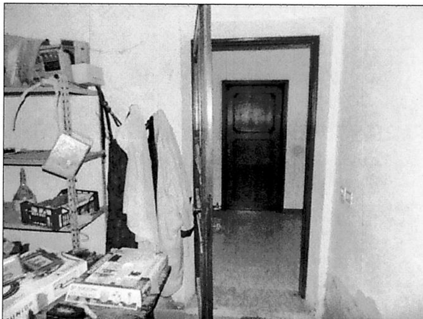
Fotografia 29: Bene p. terreno (sub. 522) – Ingresso dal vano scala condominiale
