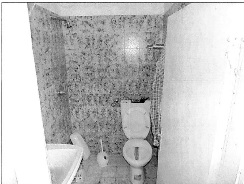
Fotografia 33: Bene p. terreno (sub. 522) – Servizio igienico
